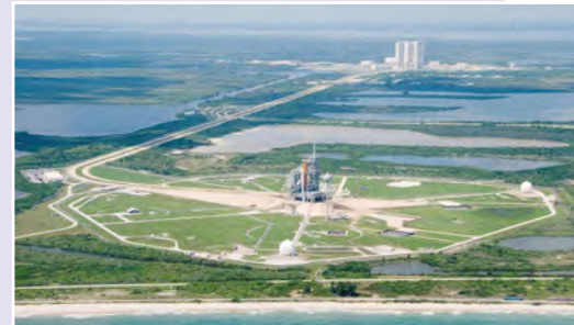
La base de Kourou. Au premier plan, l'une des deux aires de lancement. Au fond, le bâtiment d'assemblage.
